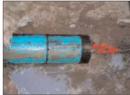
Fig. 26: Dettaglio dell'intervento di slip-lining
