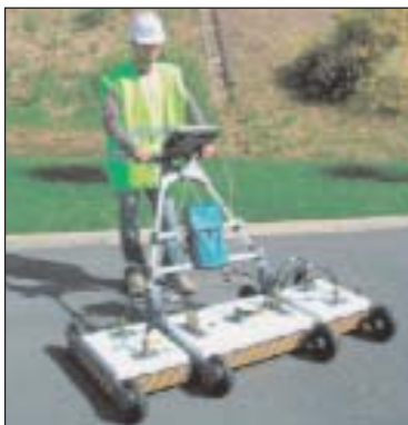
Fig. 5: Apparecchiatura Georadar per la mappatura dei sottoservizi
